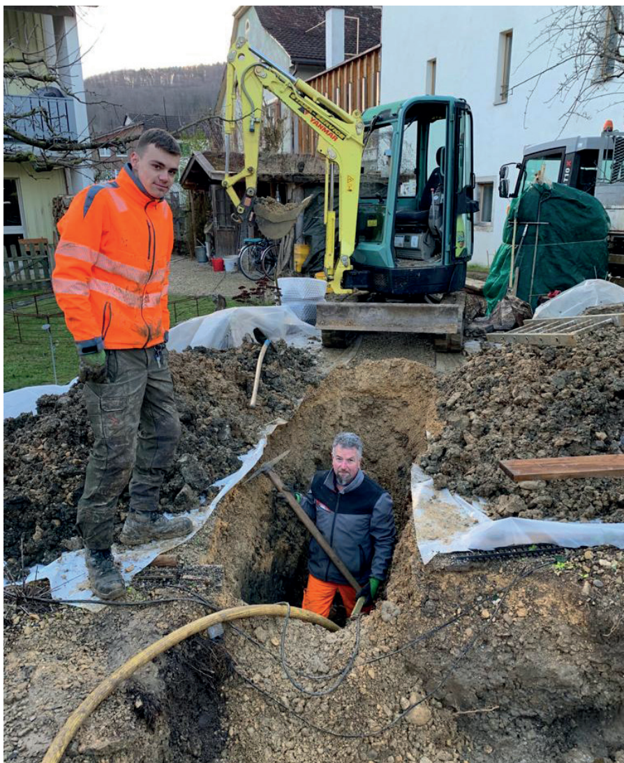
Eine funktionierende Wasserversorgung gibt immer Arbeit: Do. 24.02.2022 Stefan Dürr und Marc Leuenberger bei der Reparatur eines geborstenen Gussrohrs
