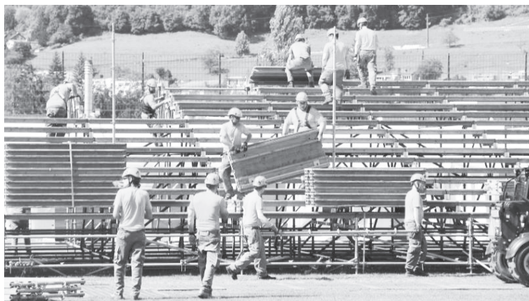
Aufbauarbeiten am Nordwestschweizerischen Schwingfest in Lausen.
