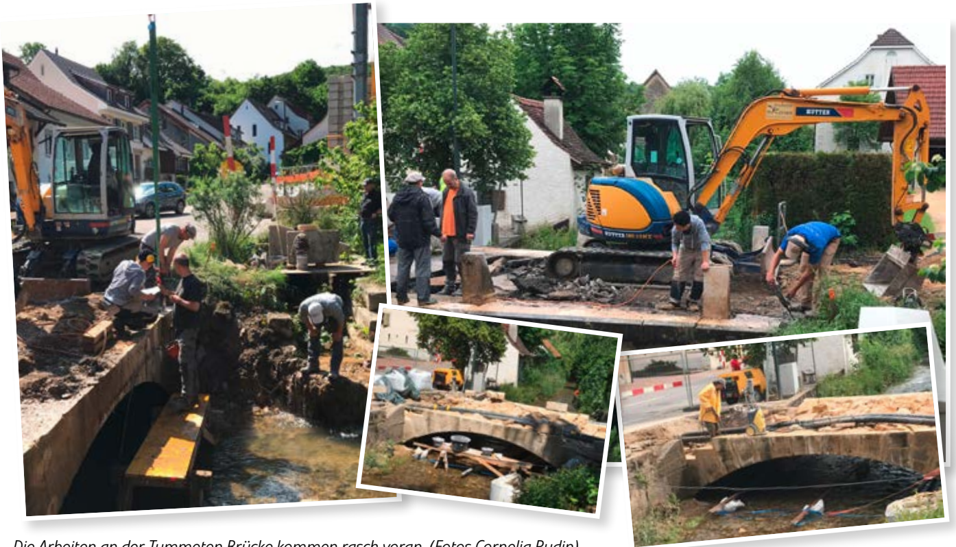
Die Arbeiten an der Tummeten Brücke kommen rasch voran. (Fotos Cornelia Rudin)
