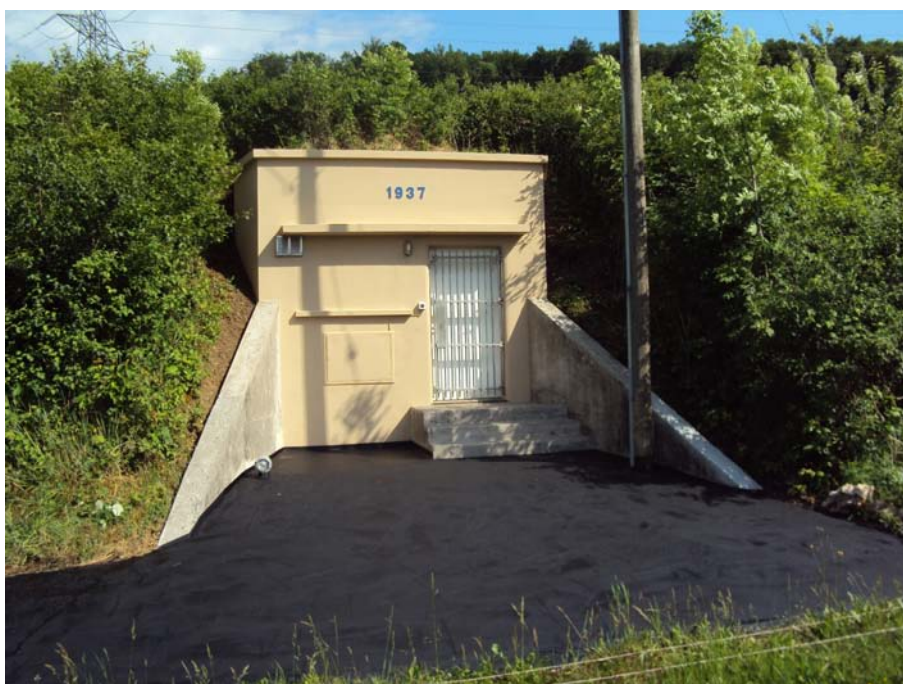
Das Reservoir Fuchs: Sanierung der Fassade und des Vorplatzes durch den Werkhof der Gemeinde (Foto Stefan Dürr)
