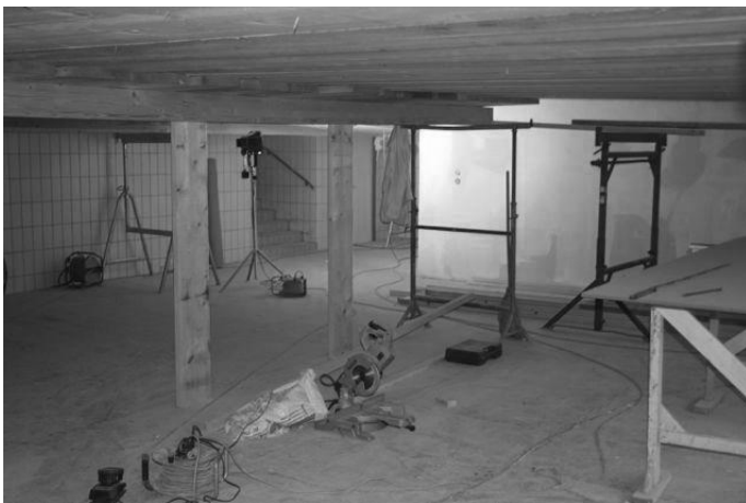
Schwimmhalle während dem Umbau
