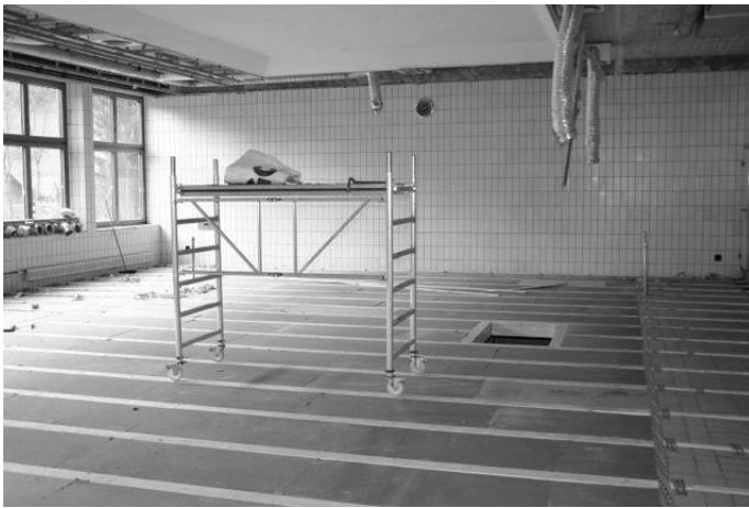
Schwimmhalle während dem Umbau
