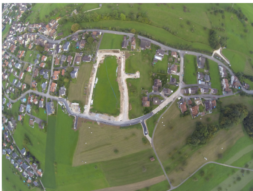
Luftaufnahme von der Baustelle „Erschliessung Hofmatt“ ....
