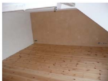
Massivholzboden Föhre / Lehmverputz
