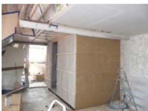
Dachausbau / Teile mit Lehm
