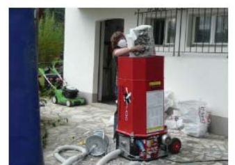
Celluloseisolation einblasen
