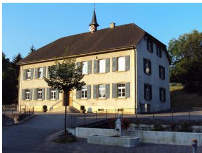
Das Gemeindehaus vor und nach der Renovation
