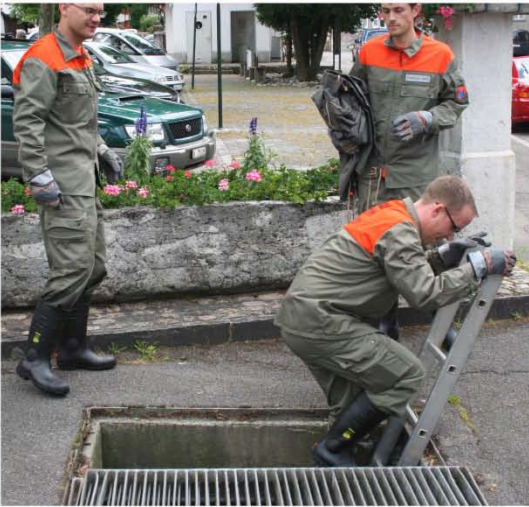
Einstieg in die Hintere Frenke durch einen Schacht im unteren Teil des Dorfplatzes.
