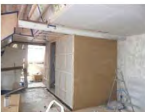
Dachausbau / Teile mit Lehm
