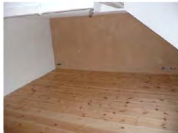
Massivholzboden Föhre / Lehmverputz
