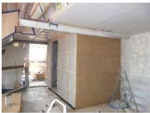
Dachausbau / Teile mit Lehm
