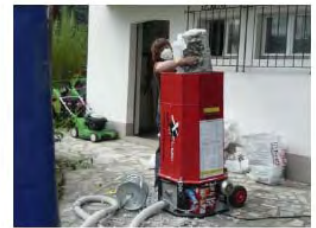
Celluloseisolation einblasen
