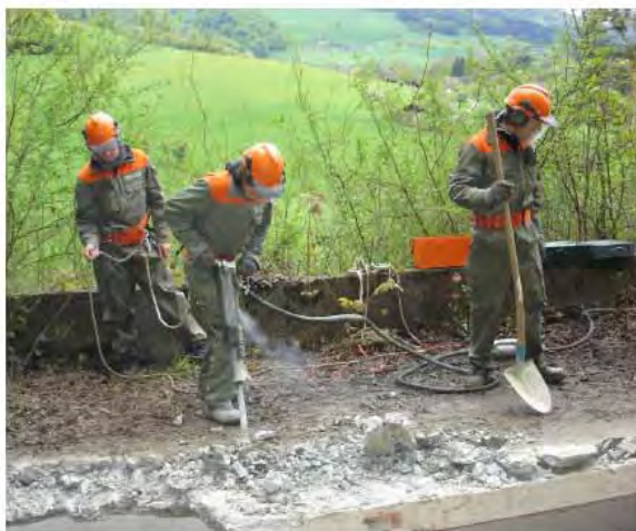
WK Frühling, Pioniere der Unterstützung beim Rückbau des alten Scheibenstandes in Bretzwil.
