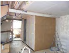
Dachausbau / Teile mit Lehm
