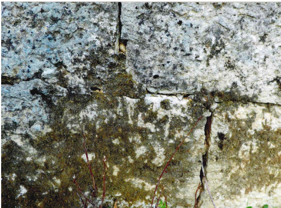
Abbildung 5: Fugenbild Schichtmauerwerk
