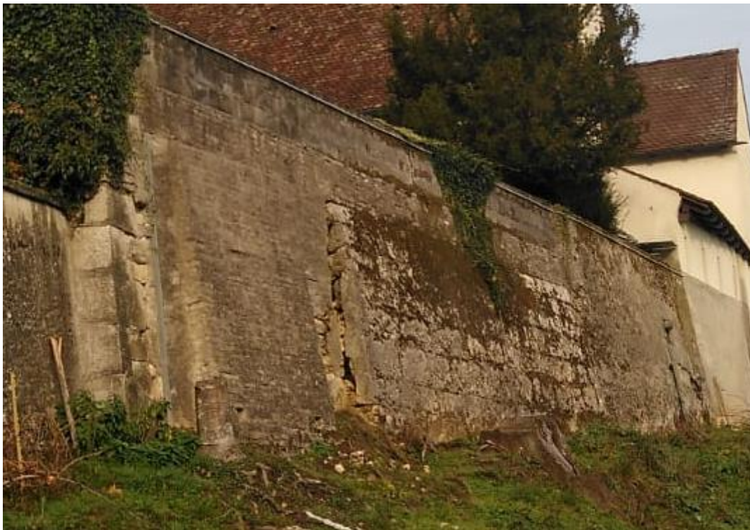
Abbildung 4: Frontalaufnahme der Stützmauer
